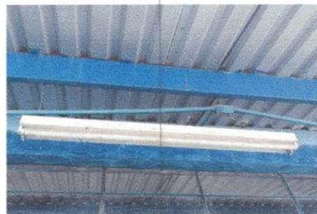
Foto 6: Sustitución de ducto eléctrico
